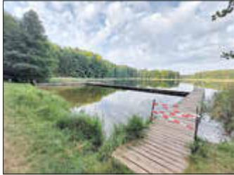
leider mussten wir den Badesteg am Mühlensee aus verkehrssicherungstechnischen Gründen sperren. Dies resultiert aus der jährlichen Hauptuntersuchung. Demzufolge muss die Steganlage umfangreich saniert werden. Mehrere tragende Balken und Bohlen weisen eine
